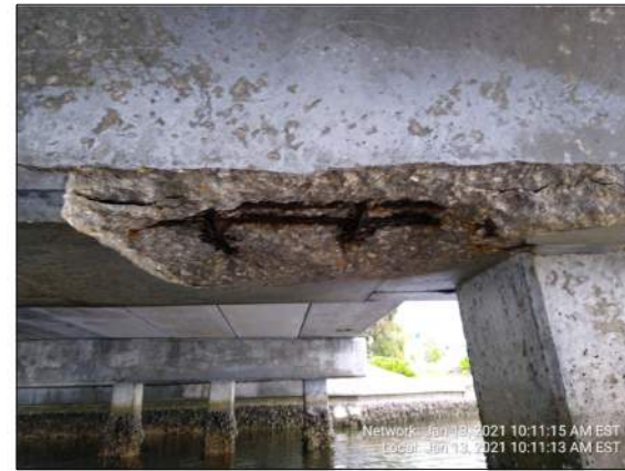
SPAN 3 - BENT 3 - BEAMS 8 & 9
